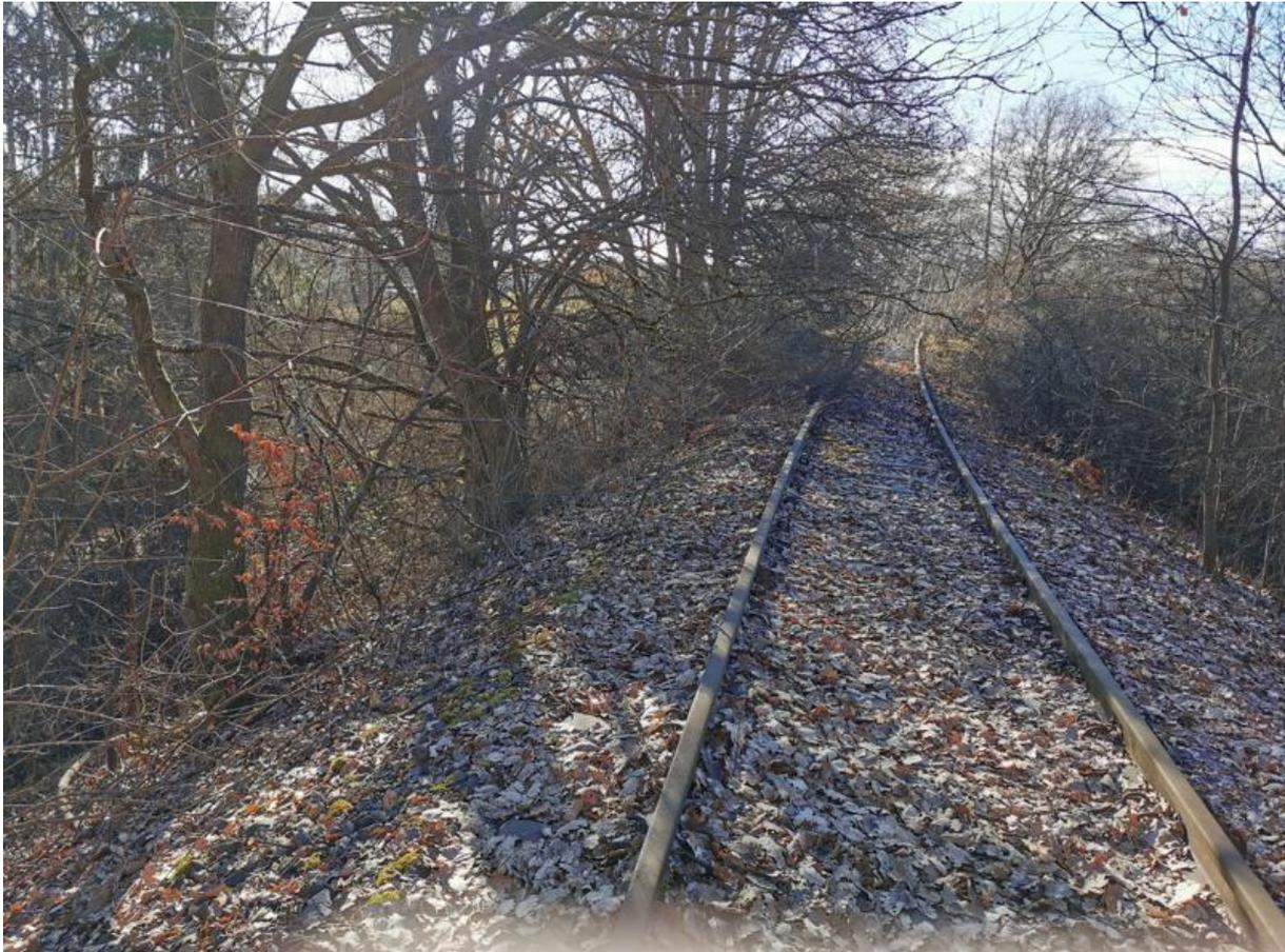
*Abbildung 6: Hoher Trassenverlauf am Bauwerk 4 benötigt Maßnahmen ab Gleisbett für einen 3 m breiten Radweg zuzüglich beiderseitiger Bankette und zur Sicherheit vermutlich Geländer auf beiden Seiten. Im Rahmen der Planung wurde auch mit höherer Geschwindigkeit, beispielsweise zukünftig mit verstärkter Nutzung durch E-Bikes, für den Ausbau der Strecke argumentiert.*
